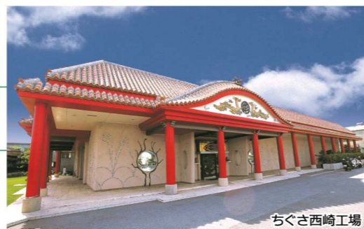
ちくさ西崎工場
